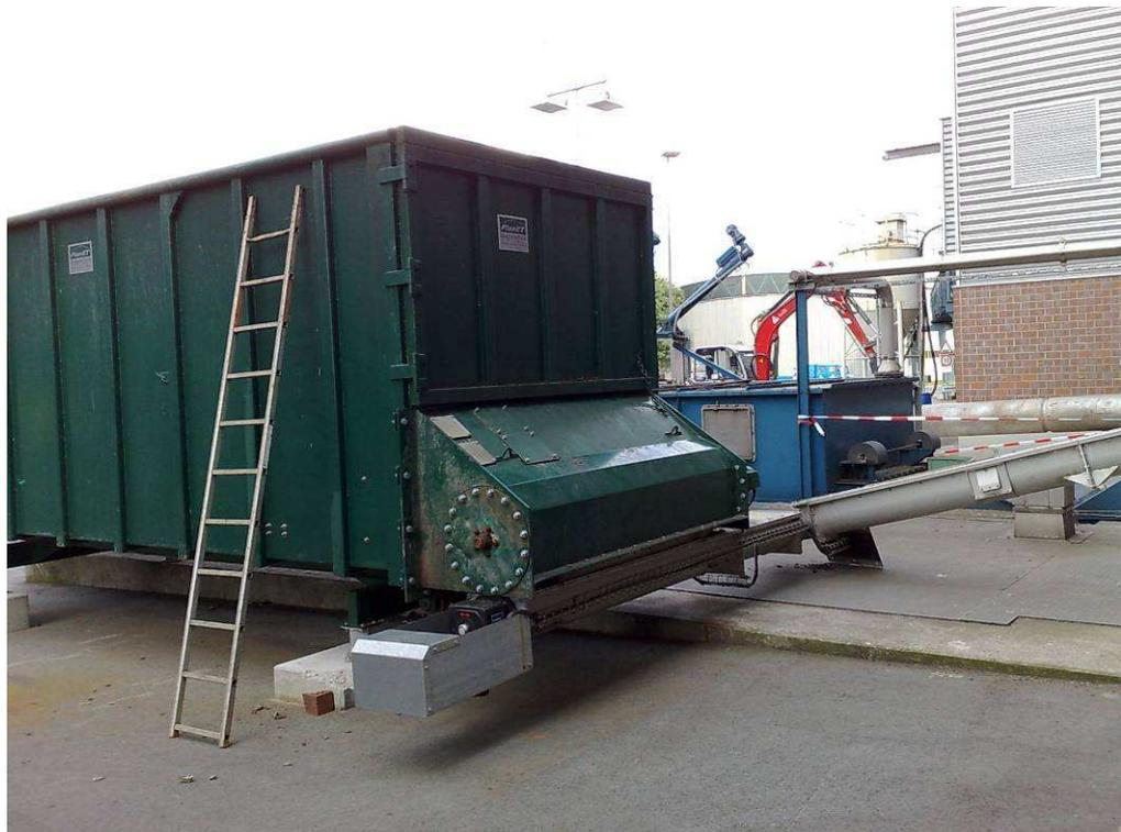
**Bild 1: Beispiel eines Vorlage- und Dosier-Containers für Ersatzbrennstoff**
