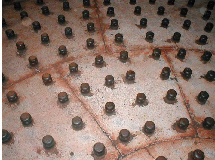
**Bild 4: Geschlossener Düsenboden**
