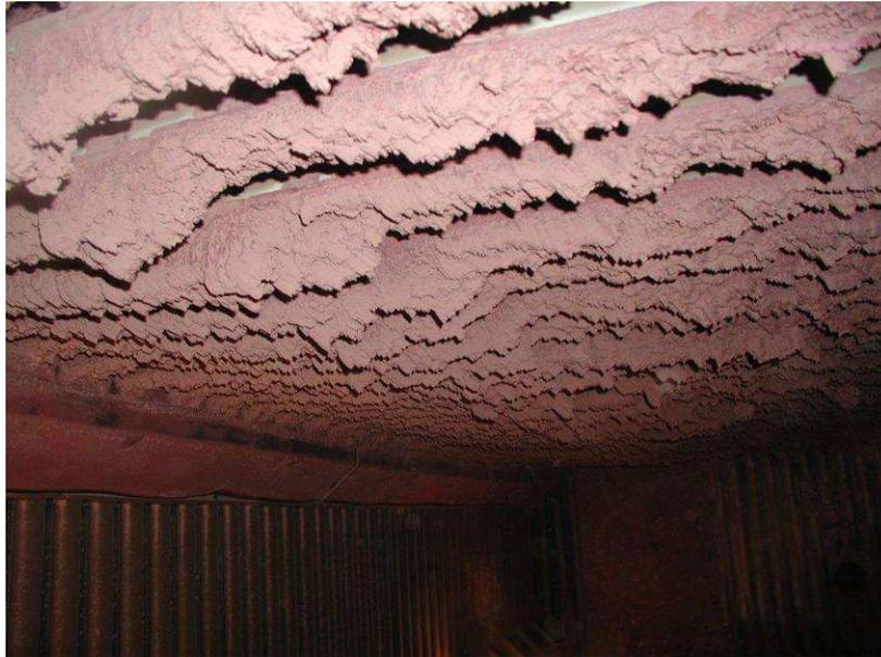
**Bild 10: Kesselverschmutzungen unterhalb der Überhitzerpakete**
